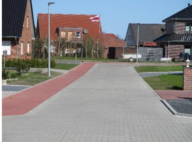
Endausbau „Oll Schoolpad“
